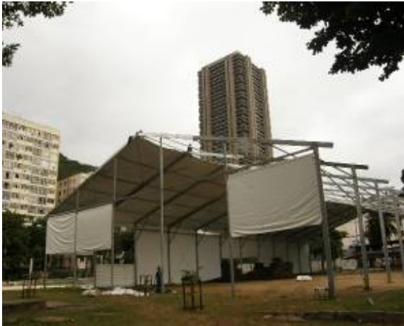
Montagem das tendas
