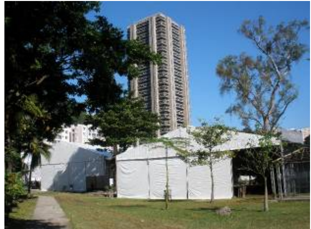
Montagem das tendas
